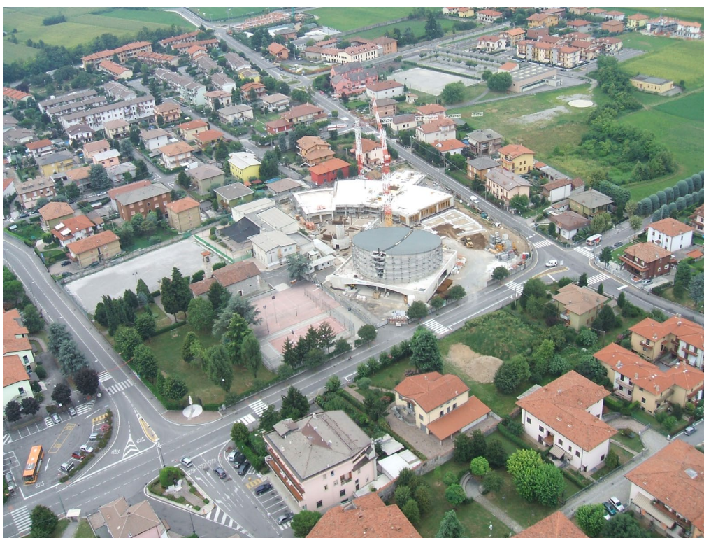
12 agosto 2008: dopo un anno di lavoro questo è lo stato di avanzamento della chiesa e degli edifici che costituiscono il complesso della scuola materna
