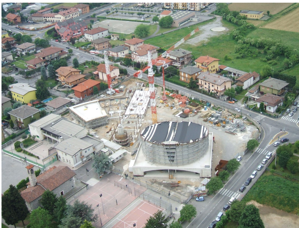
11 maggio 2008: la copertura del tetto dopo la posa delle gigantesche travi portanti
