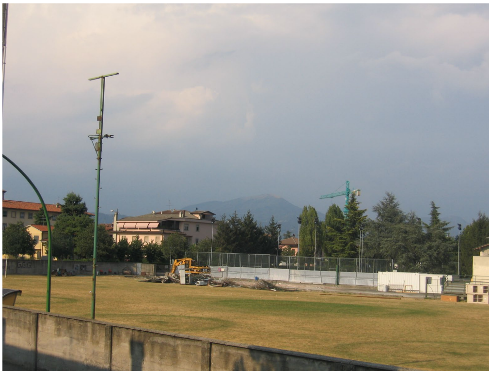
3 agosto 2007: Iniziano i grandi lavori: i mezzi meccanici liberano il terreno dell'ex campo di calcio da tutte le infrastrutture preesistenti
