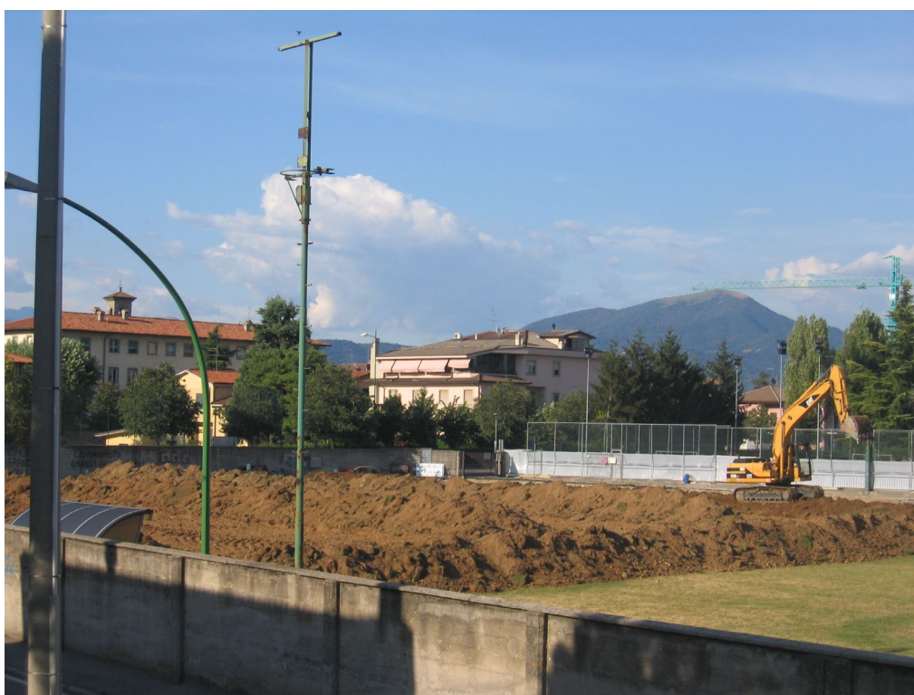
Le macchine del movimento terra hanno incominciato a spianare il terreno: il materiale rimosso viene temporaneamente depositato nelle adiacenze della casa parrocchiale
