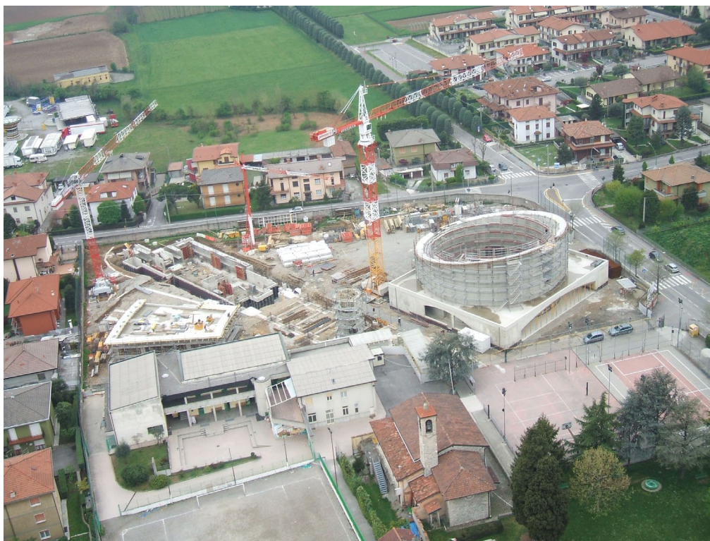
14 aprile 2008: vista d'insieme del grande cantiere con ben tre gru a lavoro
