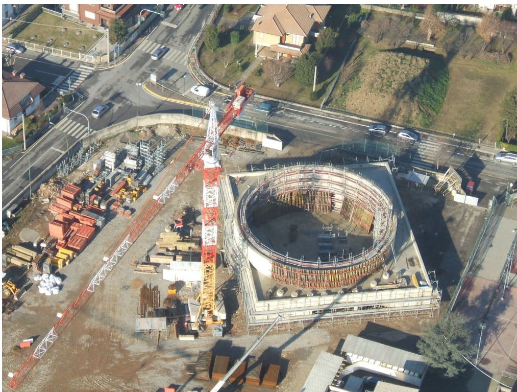
8 gennaio 2008: il freddo inverno non ferma i lavori
