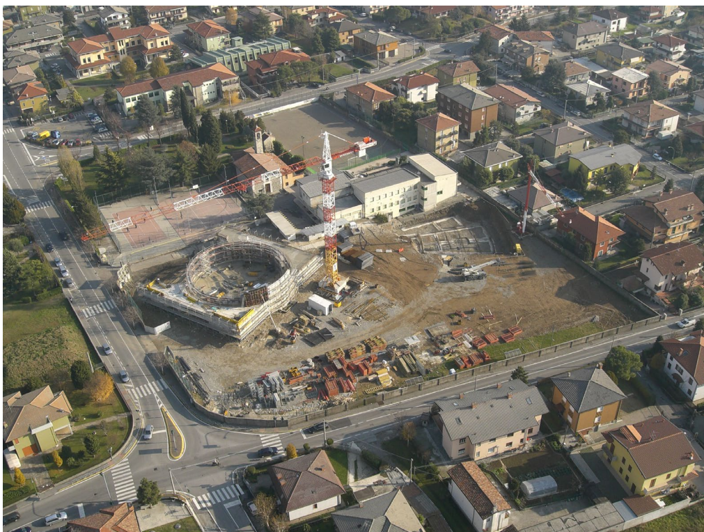
29 novembre: la costruzione si è elevata, le “mura quadrate della Gerusalemme Celeste” sono state edificate, mentre procede la chiusura dell’aula circolare destinata ad accogliere i fedeli. Nel frattempo, sono iniziati anche i lavori per la scuola materna.
