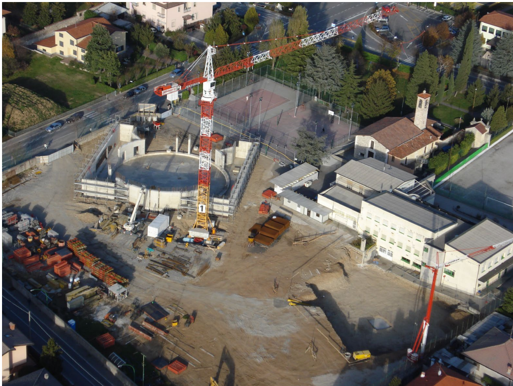
11 novembre: dall'alto sono visibili gli ingressi laterali e principale, nonché le aperture destinate alle grandi vetrate
